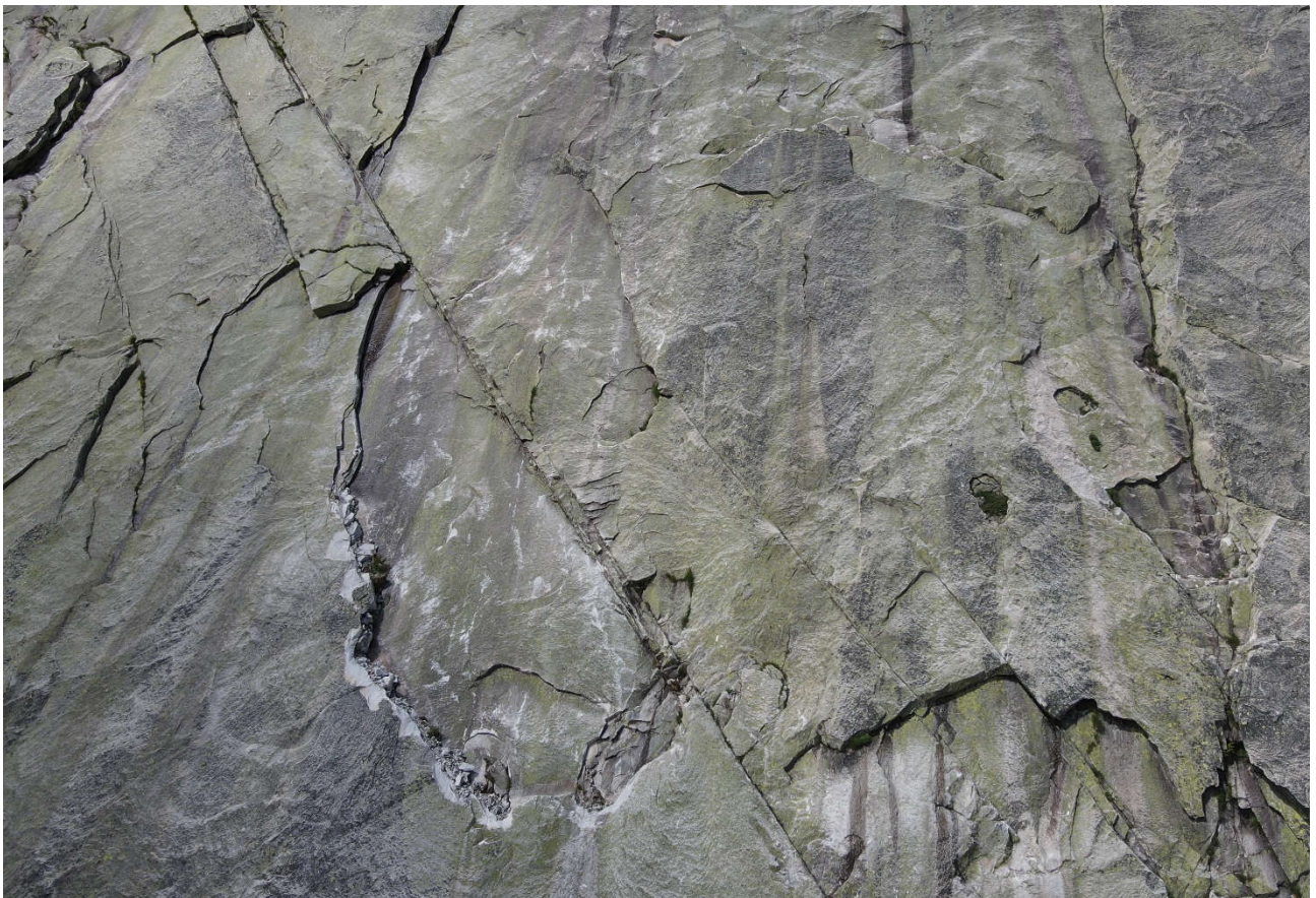
Massive Beschädigungen in den Kletterrouten, vor allem in der Route Nr. 9 "Kombination Weisser Germer-Toni". Drohnenfoto DJI_0398_W vom 23.6.2022 11:33.
