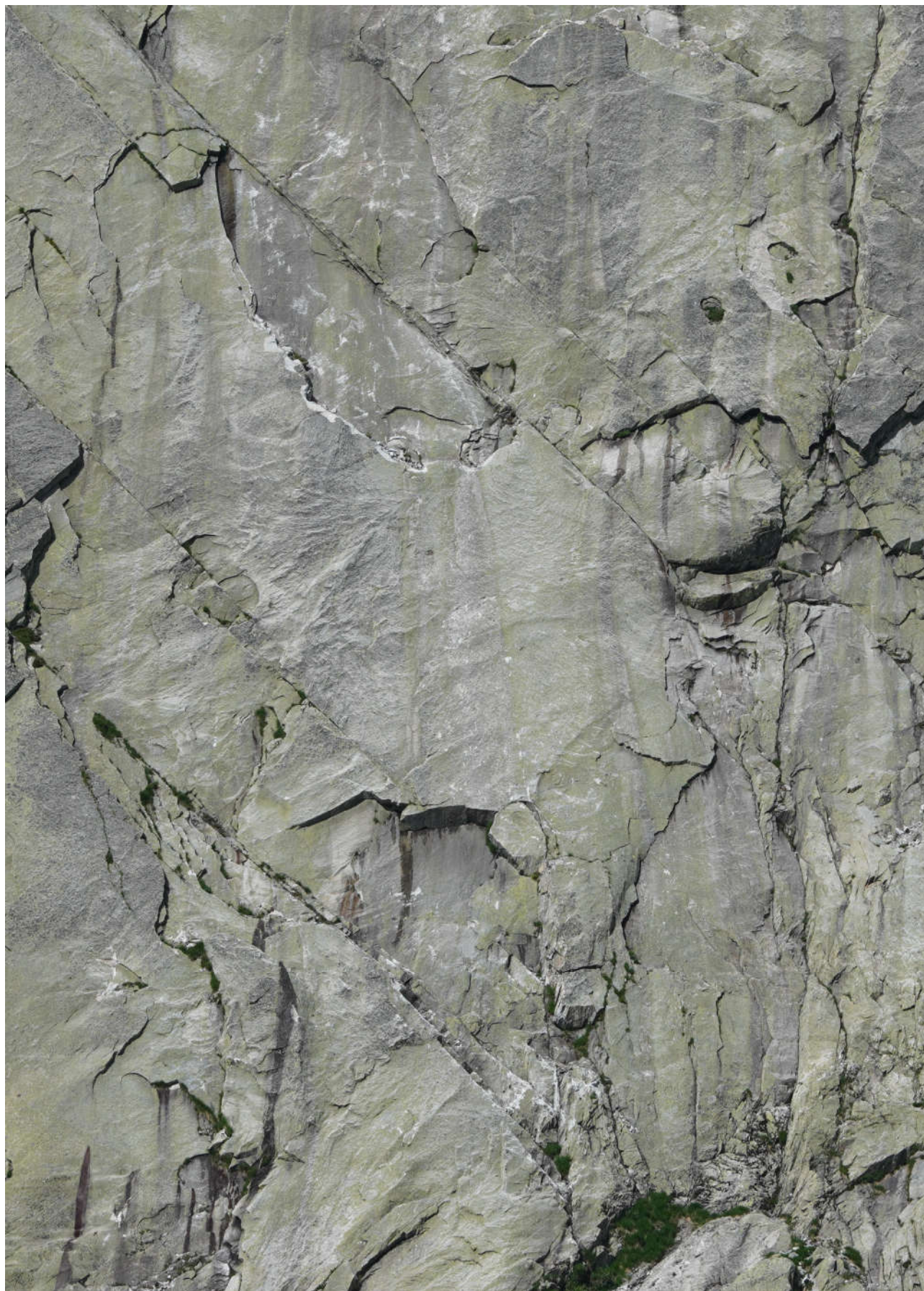
Ausschnitt: Massiv beschädigte Felsbereiche in den Routen 8 und 9 (sowie früheren Varianten) zwischen Absturznische und Wanderweg, etwa zwischen 1890 und 1830 m ü. M., Foto A6601808.
